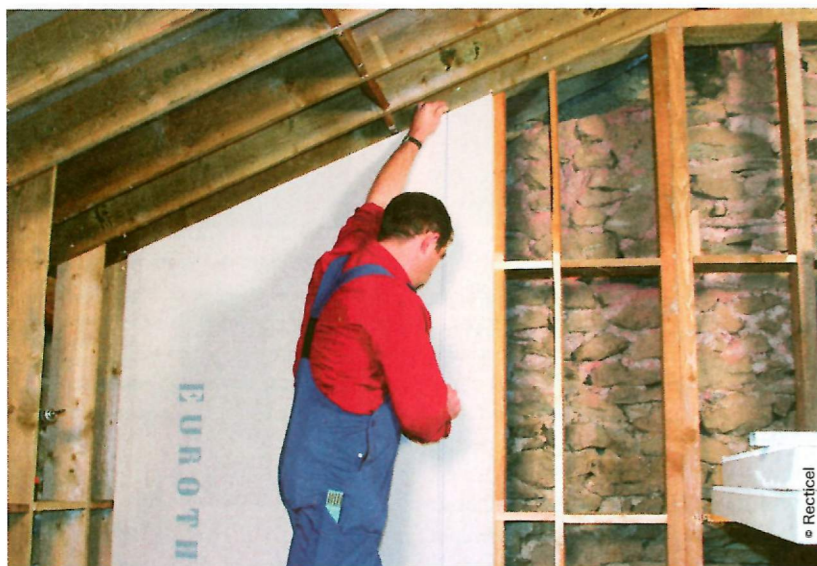
Figuur 3: bestaande massieve muur met binnengevelisolatie en gipsafwerking
