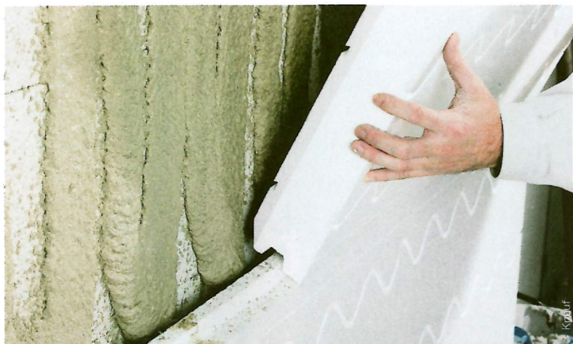
Figuur 2: bestaande massieve muur met buitengevelisolatie en bepleistering
