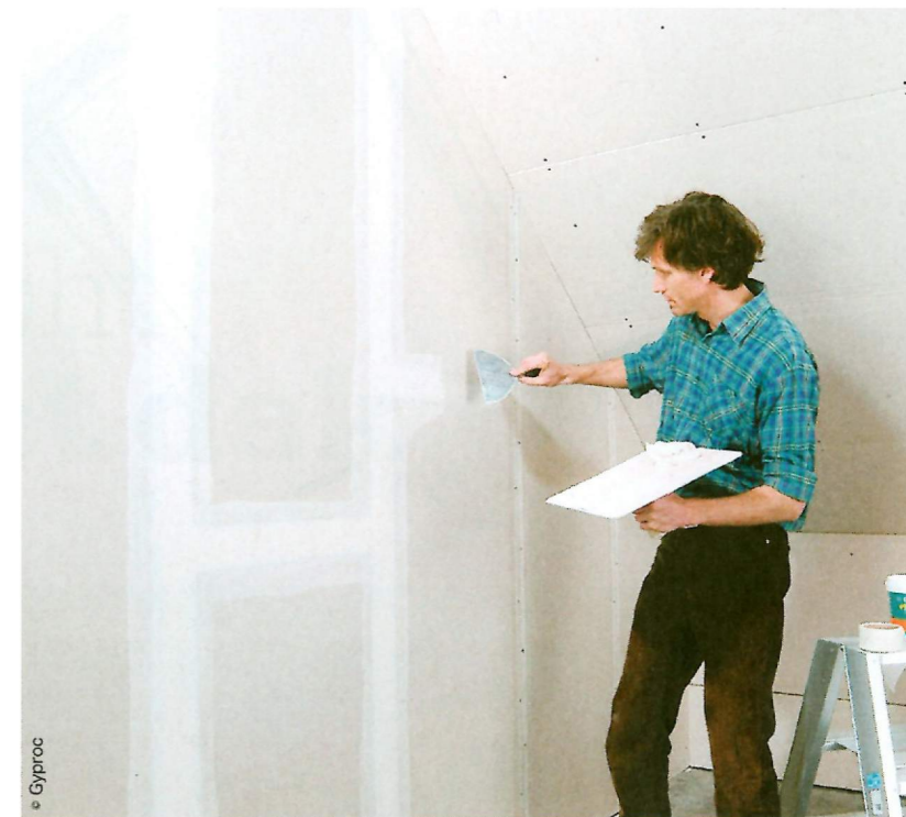
Wil je tegelijk ook het akoestisch comfort in een ruimte verbeteren, plaats je best een structuur die losstaat van de eigenlijke constructie. Op die manier worden geluidstrillingen tegengehouden.
