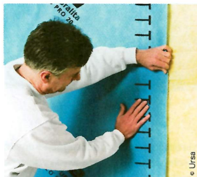
Inwendige condensatie heeft heel wat nefaste gevolgen. Het is daarom uiterst belangrijk om de isolatie te beschermen met een dampdichte folie. Dit komt ook de luchtdichtheid ten goede.
